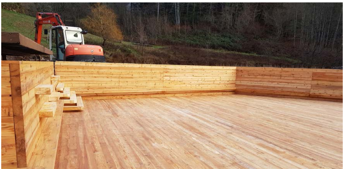
Konstruktion Holzwände Schwimmbereich (Hariyo GmbH)
